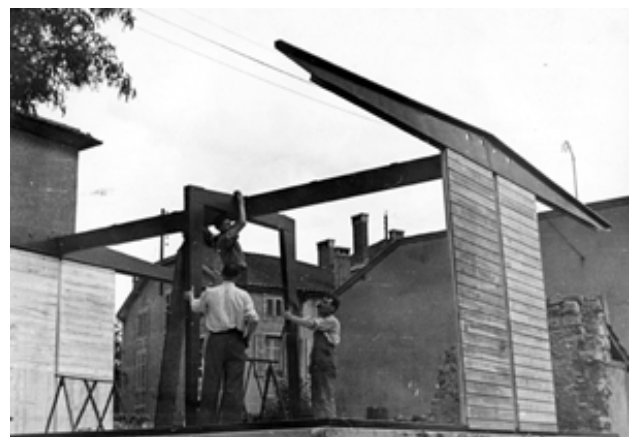
6 × 6m 組立建築 1945
