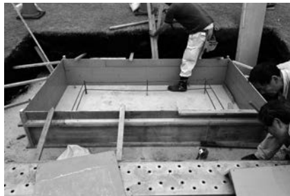
清水九兵衛《BELT》の基礎工事
