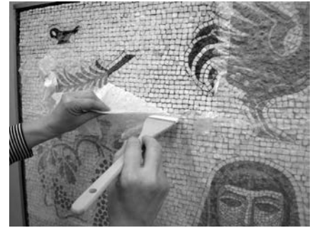
図7 裏面作業時の養生除去
