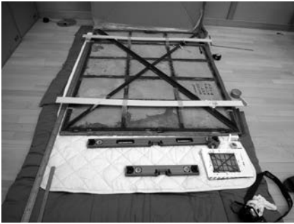
図5 仮素材での設置金具の事前確認
