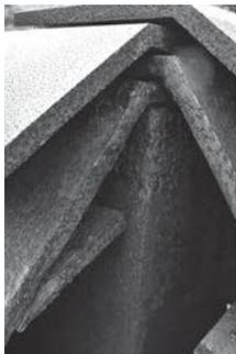
図1 修復前 錆で表面が腐食している
