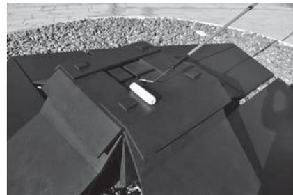
図6 修復中 ローラーによるパラフィンの量の調整
