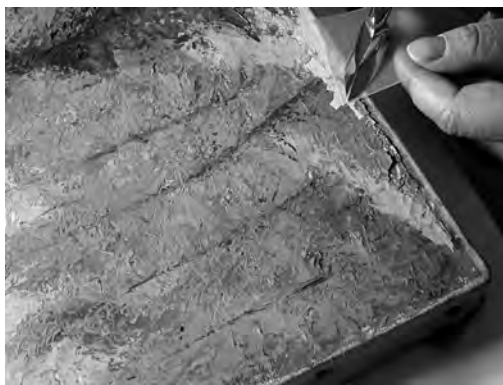
図4. 修復中 浮き上がり接着作業
