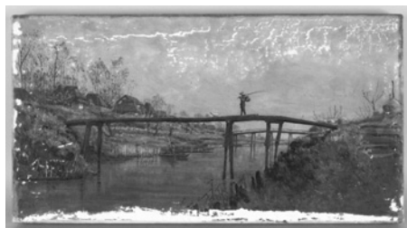
〈修復中〉剥落部分に充填整形を施した。
