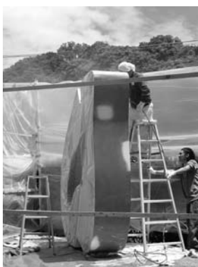
7. 〈修復中〉損傷部下塗りプライマー塗装、作業スナップ
