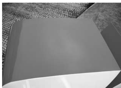
3. 〈修復後〉天井面仕上げ塗装後
