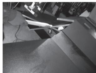
図 39. 清掃後にパラロイド B-27 の 5% アセトン溶液をローラーを用い塗布
