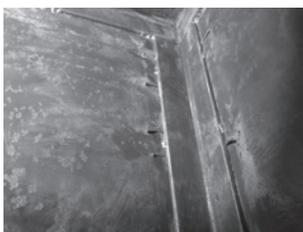
図 37. 作品表面の平面を調整するためのピンが見られた
