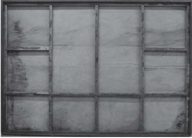
図7. 修復中 裏面のベニヤ板取り外し後 下辺を中心に冠水のしみ痕に黒カビが生じている
