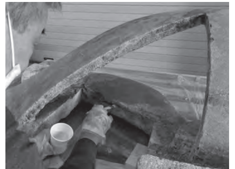
図5 修復中 刷毛で錆転換型プライマーを塗布した
