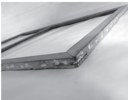
図7 修復中 木枠の釘穴の充填
