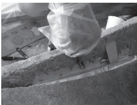
図9 修復中 欠損部をモルタルバインダーで充填し整形した
