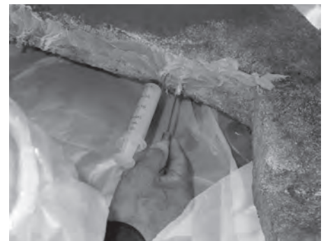
図8 修復中 大きな亀裂にはシーリングを施し注射器を用いてエポキシ樹脂を注入した
