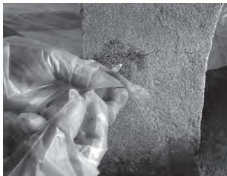
図7 修復中 細かな亀裂には注射器を用いてエポキシ樹脂を注入した
